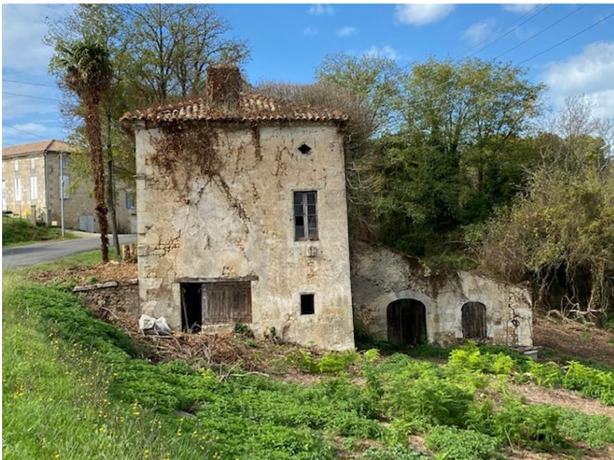
Photos du bâti (parcelle B 1471 en bordure de la RD 145)
